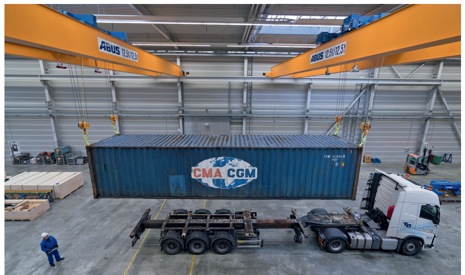
Mit modernen Kransteuerungen können bis zu zwei Katzen auf zwei Kranen synchronisiert und für gemeinsame Hubaufgaben eingesetzt werden.
