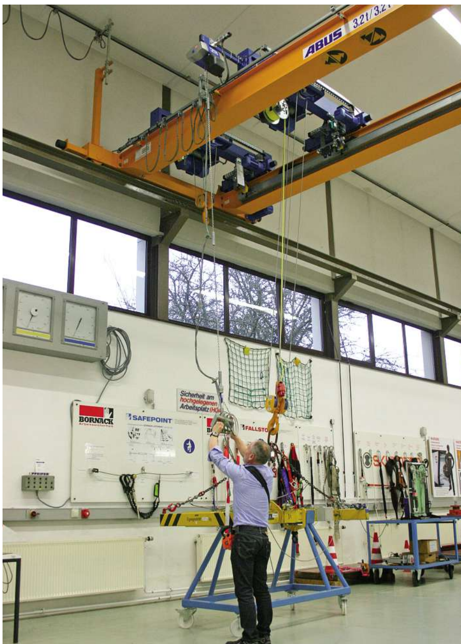
Bild 1: Zum Anschließen der Traverse an das Lastmesssystem lässt der Trainer die Anschlussdose mit dem separaten Kettenzug herunter. Über ein Schleppleitungssystem werden die Messdaten übertragen.
