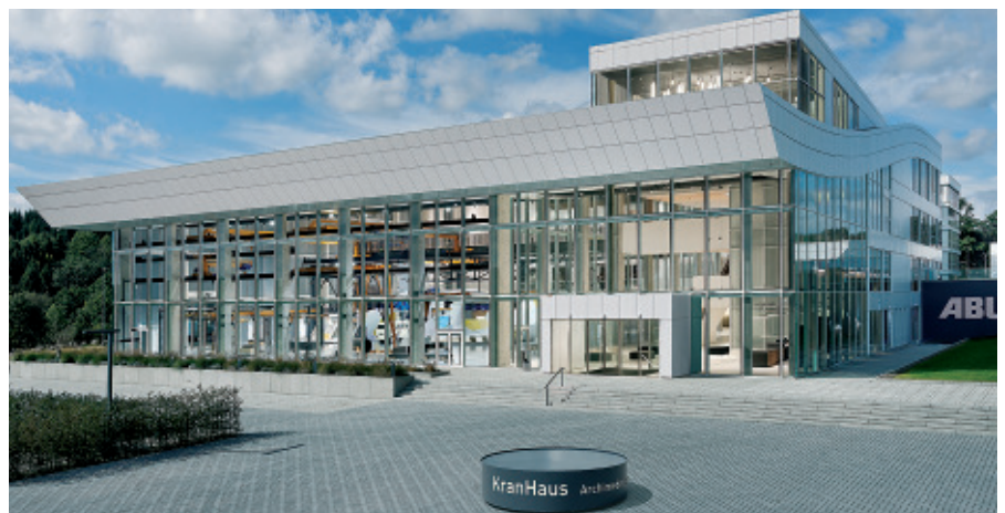
Das »KranHaus« beinhaltet auch ein Schulungszentrum für Kran-Seminare.
