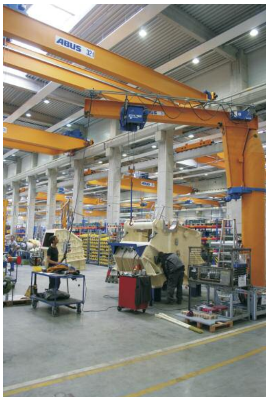
Bei der Montage setzt der Mitarbeiter einen Schwenkkran mit Seilzug ein. Dank der verfahrbaren Steuerung ist die Position des Kranführers unabhängig vom Seilzug
