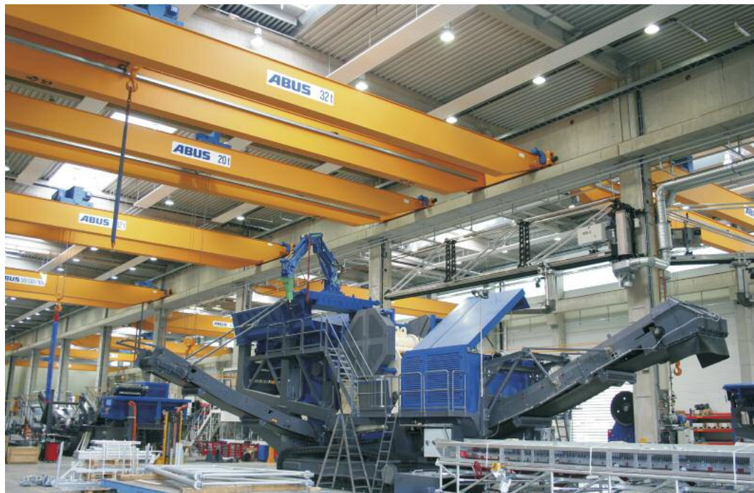
Im gesamten, neu errichteten Kleemann-Werk in Göppingen werden Abus-Laufkrane eingesetzt, um solche mobilen Brecher-Anlagen präzise zu montieren
