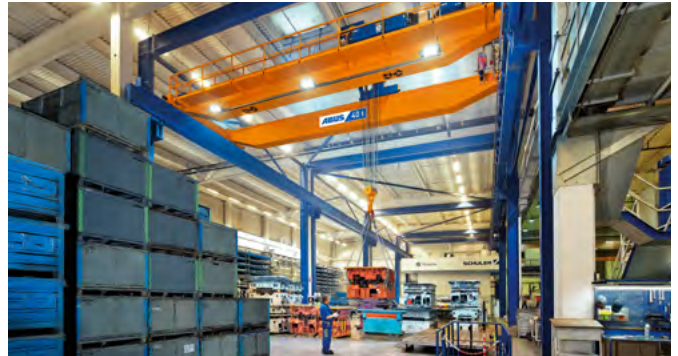
Bestückung mechanischer Bearbeitungsmaschinen
