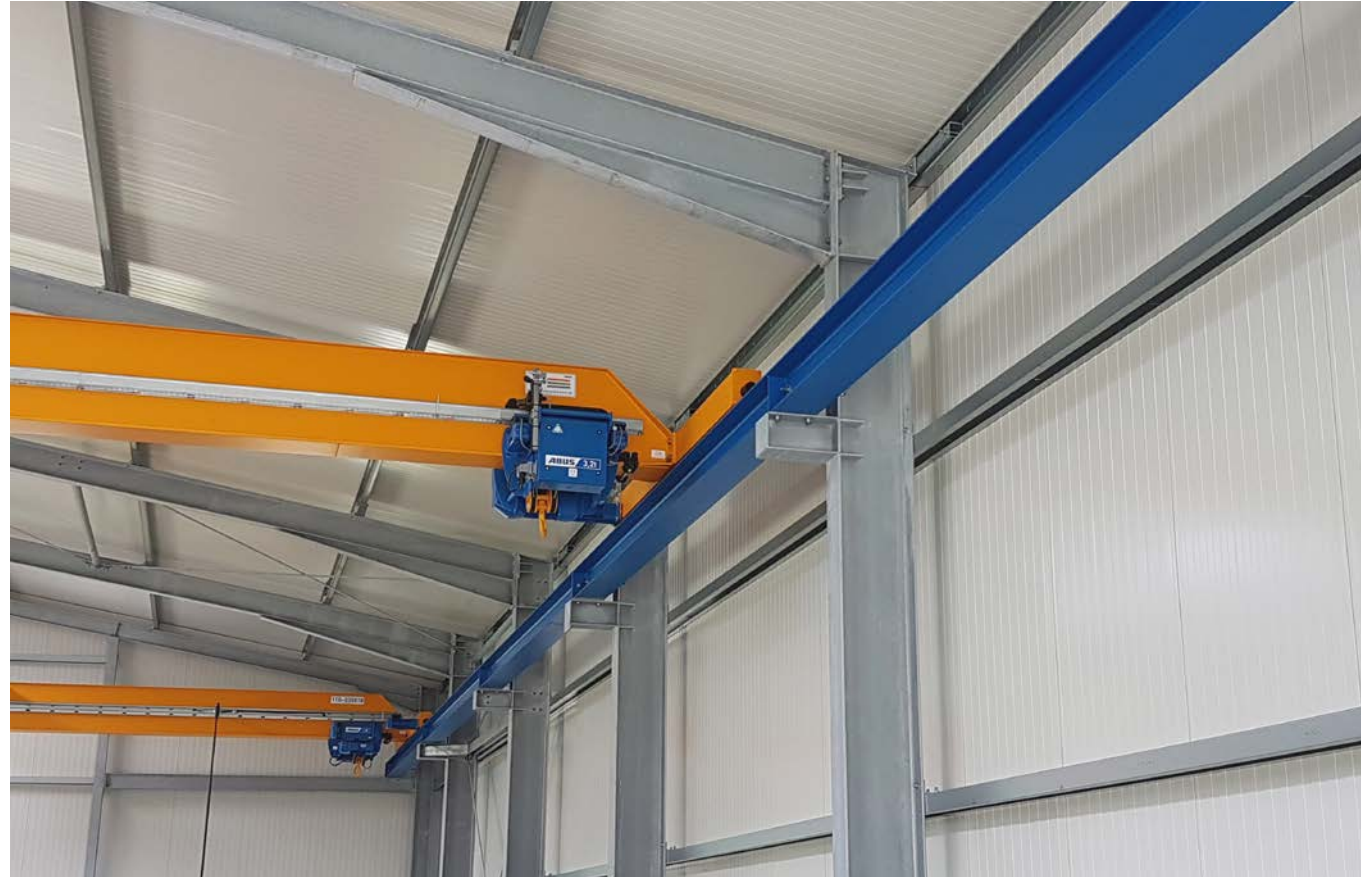
Kranbahn nach der Montage
